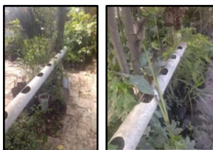
Figura 3: Tubos de pvc de hidroponia, en desuso por falta de insumos.
